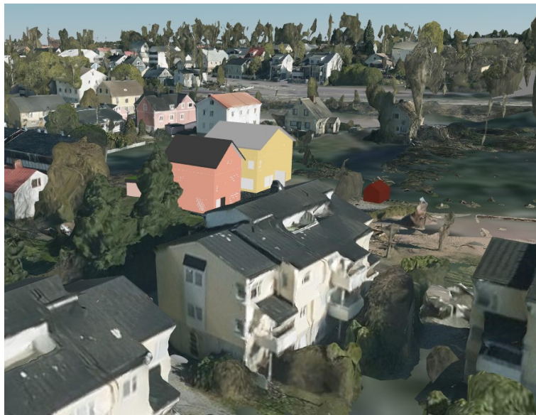
Kuva 8. Kuvassa 3D kaupunkimalliin upotettuna yksi asemakaavamuutoksen mahdollistama vaihtoehto. Näkymä kaava-alueelle etelän suunnasta. Uudisrakennukset näkyvät kuvan keskellä persikan ja keltaisen värisinä rakennuksina.
